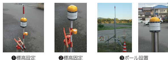
① 標高設定 ② 標高固定 ③ ポール設置
